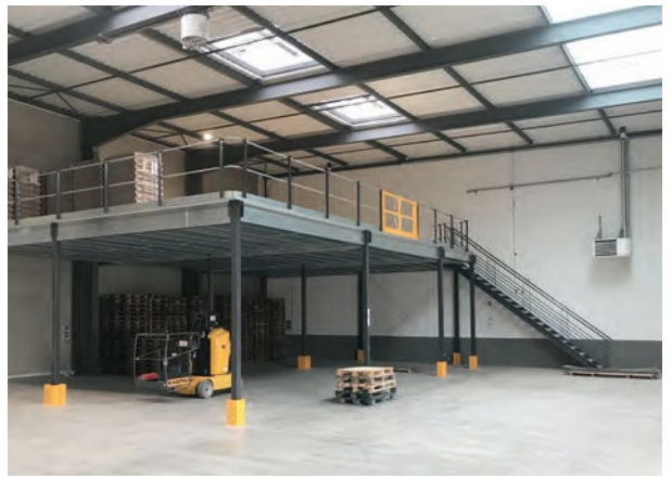
Redoublement d'une surface de stockage avec une plateforme équipée d'une rambarde et d'un portillon à retour automatique pour le chargement/déchargement de palettes à l'étage en toute sécurité (Araydis)
