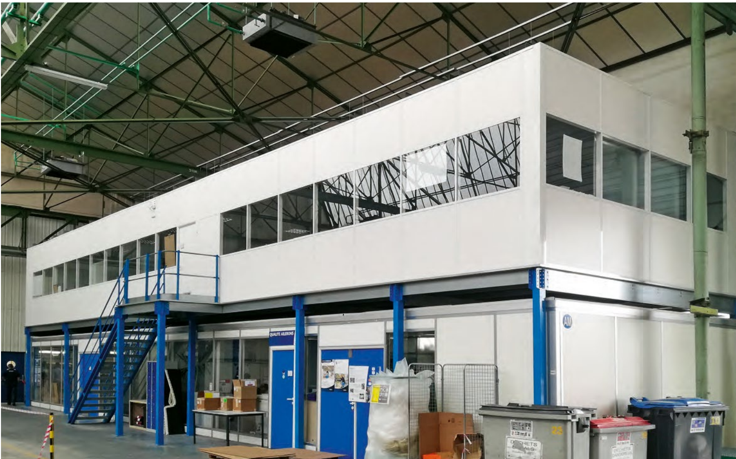
Exploitation de la hauteur d'un bâtiment pour l'ajout de bureaux sur une plateforme, au-dessus de bureaux existants (Merial Bordeaux)
